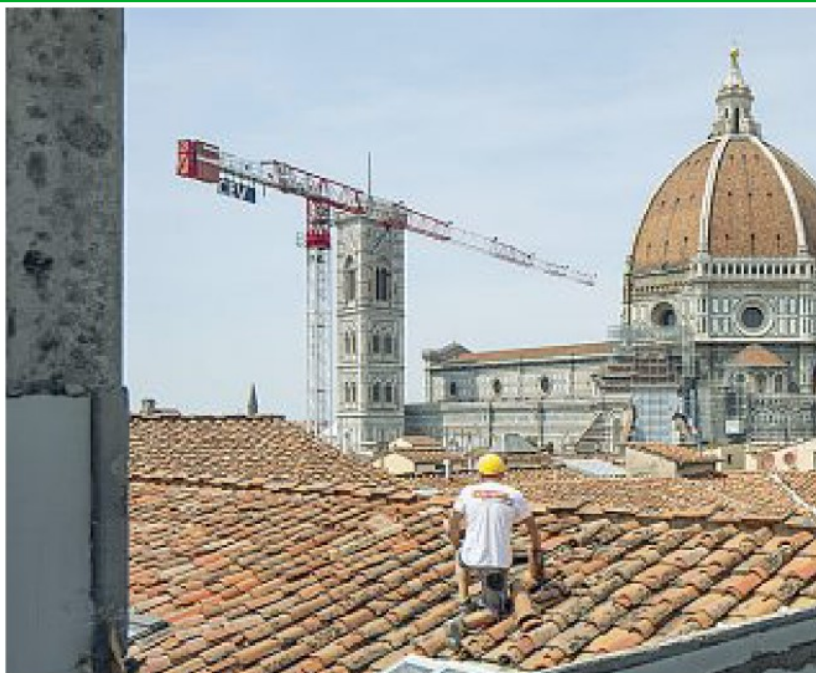
Al lavoro Un cantiere del gruppo Spagnoli nel centro di Firenze
